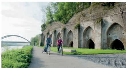
RAVeL de l'Escaut, four à chaux Saint-André (Tournai)
