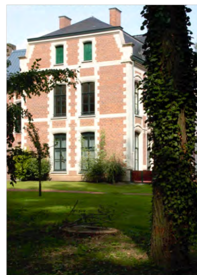
Six peupliers présentant un réel risque ont d'ores et déjà été abattus, à l'instar de celui-ci dont il ne reste que la souche, non loin de la crèche halte-garderie.
